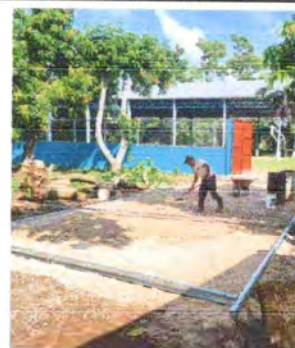
Foto 12: Se da inicio a la reparación de la plancha de concreto de patio que da el ingreso al centro educativo.
