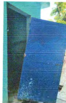
Foto 8: Se desmontan las puertas de los baños para darle mantenimiento y ser lijadas, cepilladas y pintadas.
