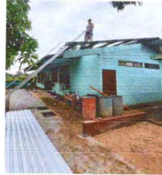
Foto 2: Se inicia con el cambio de las láminas deterioradas por lámina troquelada aluzinc calibre 26.
