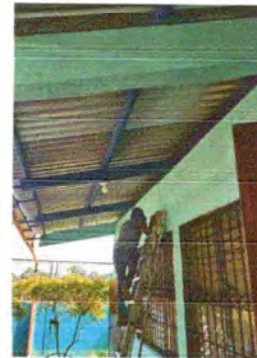
Foto 4: Se empiezan a dar mantenimiento a la estructura de soporte de metal que se encuentran deterioradas.
