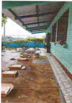
Foto 3: Colocación del piso cerámico en el corredor.
