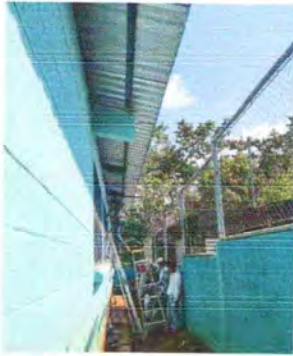
Foto 1: Se observa como se trabaja en la colocación del canal de metal para el desfogue de agua pluvial.
