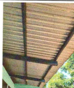
Foto 4: Se observa que las costaneras se encuentran deterioradas.
