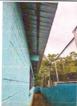
Foto 1: Se observa que no cuenta con canal para el desfogue de agua pluvial.
