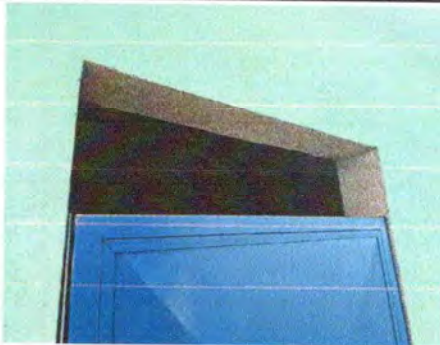
Foto 9: No se cuenta con balcones de metal.
