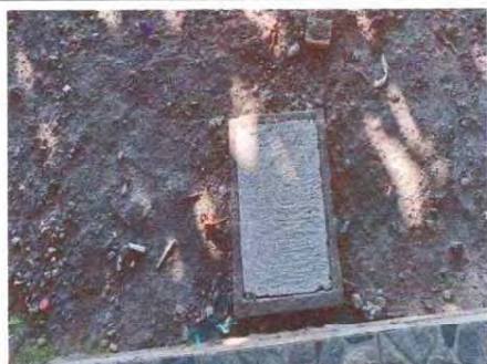
Foto 17: Se observa el cambio de tapadera de caja.
