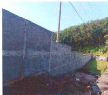
Foto 18: Se observa la aplicación de repello a los muros.
