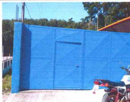
Foto 14: Se observa el mantenimiento del portón
