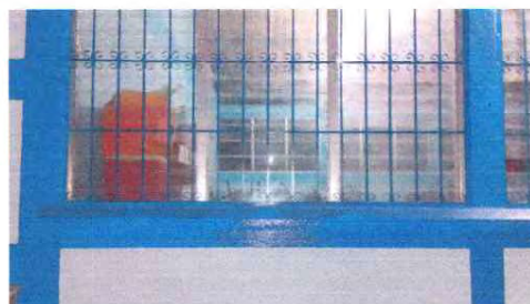
Foto 10: Se observa la reposición de vidrios en las ventanas
