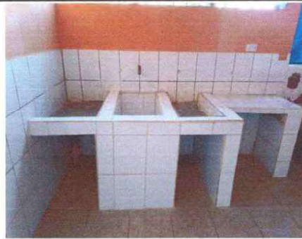
Foto 2: Se observa la realización de la pila de concreto, la cual se colocó en este sitio.
