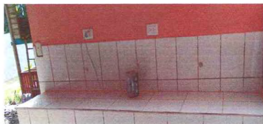
Foto 4: Se observa la instalación del sistema eléctrico
