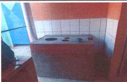
Foto 1: Se observa la realización de la estufa rural, la cual se colocó en este sitio.
