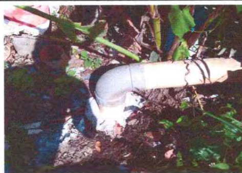
Foto 16: Se observa la sustitución de tubería de pvc de línea principal de aguas pluviales que se colocó bajo tierra.
