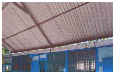
Foto 12: Se observa colocación del canal de metal en lugar del pvc
