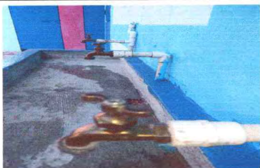
Foto 15: Se observa el cambio de las llaves de los chorros
