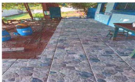
Foto 8: Se observa la colocación del piso cerámico
