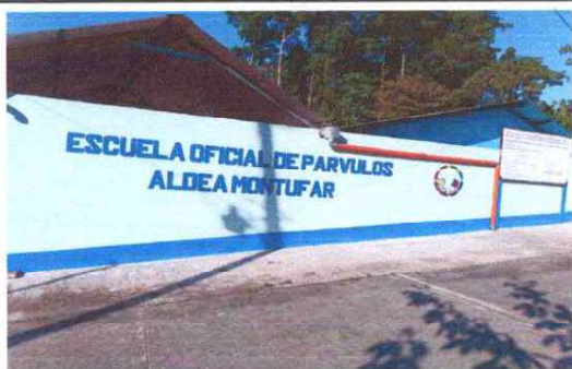
Foto 13: Se observa el alisado y pintura de los muros
