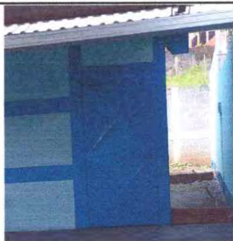
Foto 9: Se observa el mantenimiento de la puertas
