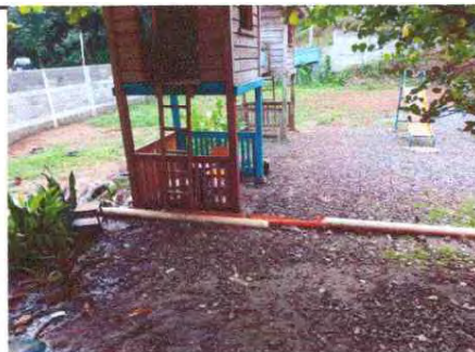
Foto 16: Se observa la sustitución de tubería de pvc de línea principal de aguas pluviales que se conectará a la tubería de la caja para que no quede sobre la tierra.
