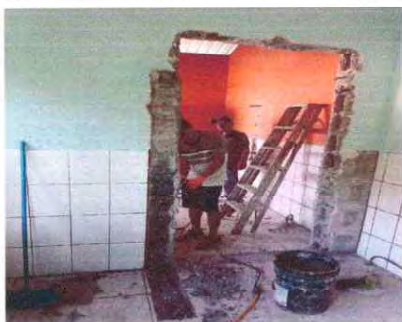
Foto 5: Se observa la pared que se abrió para la conformación de la puerta
