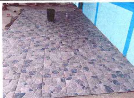
Foto 8: Se observa la colocación del piso cerámico
