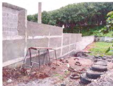
Foto 18: Se observa la aplicación de repello a los muros.
