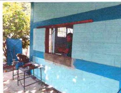
Foto 6: Se observa la pared que se abrió para la conformación de la ventana
