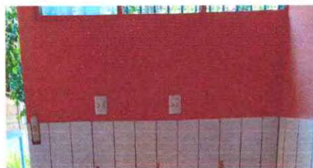
Foto 4: Se observa la instalación del sistema eléctrico
