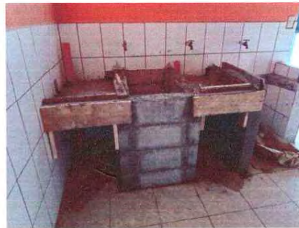
Foto 2: Se observa la de realización de una pila de concreto, la cual se colocó en este sitio
