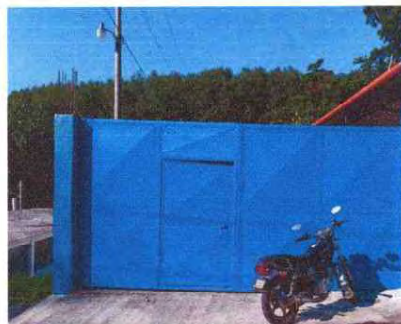
Foto 14: Se observa el mantenimiento del portón
