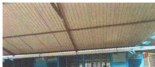
Foto 12: Se observa la necesidad de sustituir el canal de pvc por metal
