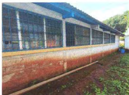
Foto 11: Se observa la necesidad de darle mantenimiento a la ventana de metal
