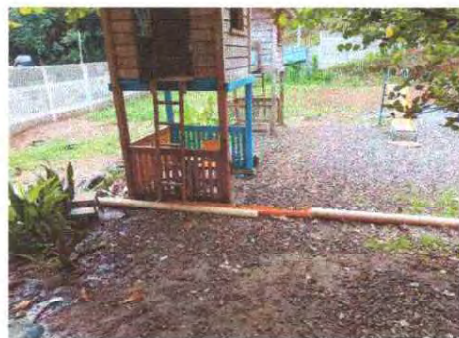
Foto 16: Se observa la necesidad de sustituir la tubería de pvc de linea principal de aguas pluviales
