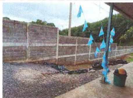
Foto 18: Se observa la necesidad de aplicar el repello en los muros
