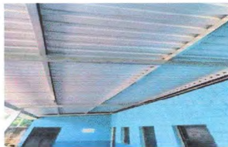
Foto 2: Se observa que el techado está terminado.
