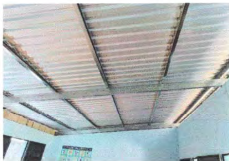
Foto1: Aquí el proceso de cambio de láminas ya está concluido.
