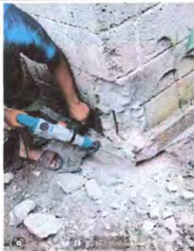
Foto1: Se observa el proceso para colocar la columna respectiva.
