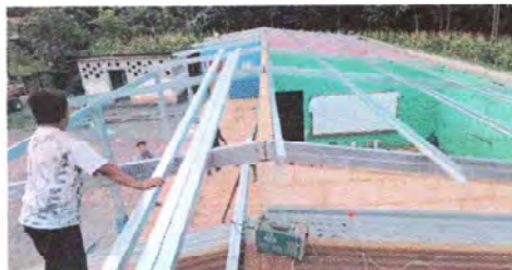
Foto 2: Se observa el cambio de madera por estructura.
