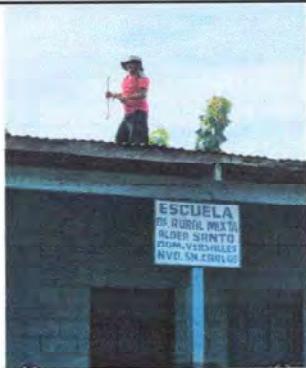
Foto1: En esta imagen se observa el proceso del cambio de láminas del techado.
