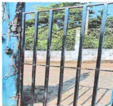
Foto 2: Se observa el proceso del cambio de portón.
