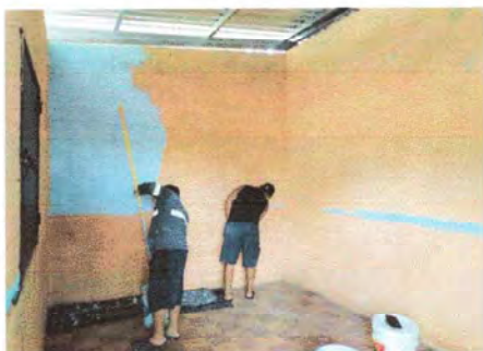
Foto 3: Se observa el proceso del resane.
