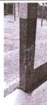
Foto 2: Se observan columnas en mal estado, con el acero expuesto. Por lo que necesitan ser reparadas.
