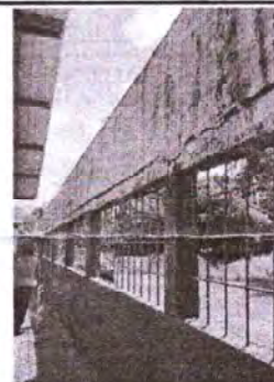
Foto 4: Se observa que el muro perimetral se encuentra en mal estado, se pueden apreciar aceros expuestos en las soleras superiores. Es necesario repararlo. A su vez se observa que los balcones deben recibir mantenimiento
