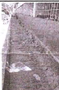
Foto 3: Se observa que es necesaria la conformación de banqueta tras el módulo, para evitar que se dañe próximamente el desplante del módulo de aulas.
