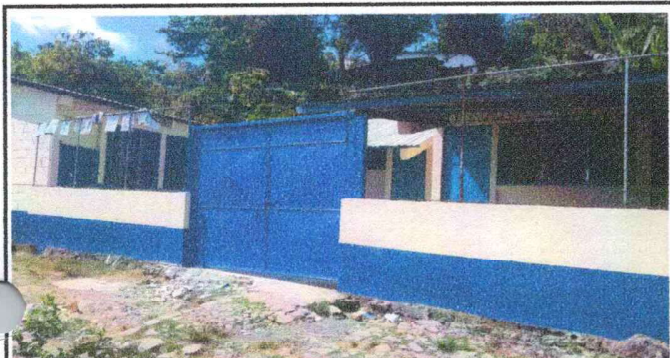
Foto 3: Susticion de puerta por porton finalizado
