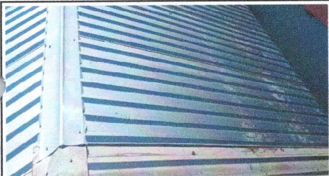
Foto1: Sustitucion de lámina por laminá troquelada terminada a cabalidad
