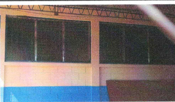
Foto 4: Instalacion de persianas completadas
