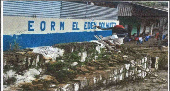
Foto 2: se estan pintando las paredes
