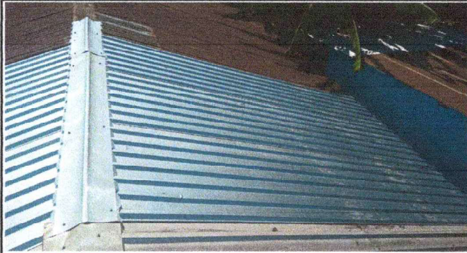
Foto1: Colocando lamina nueva
