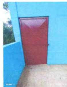
Foto 2: Se observa la puerta despues del mantenimiento
