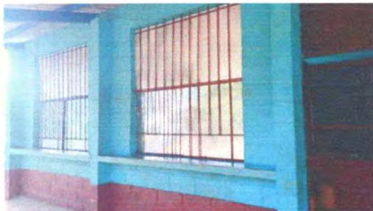
Foto 1: Se observa como quedaron los balcones despues del mantenimiento
