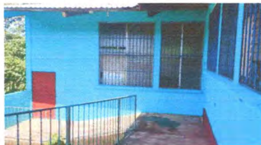
Foto 4: Se observa como quedaron los muros con la aplicación de pintura en los muros
