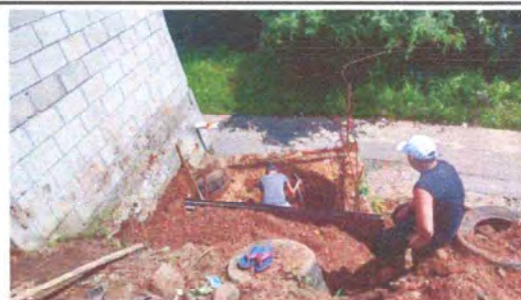
Foto 6: Se observa la colocacion del biodigestor
