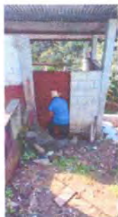
Foto 7: Se observa la sustitución de las puertas de metal de los baños
