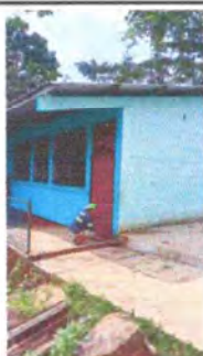
Foto 3: Se observa el cambio de puerta en las aulas
