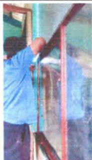
Foto 1: Se observa que se esta realizando mantenimiento a los balcones de las aulas
