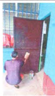
Foto 2: Se observa el mantenimiento de las puertas en las aulas
