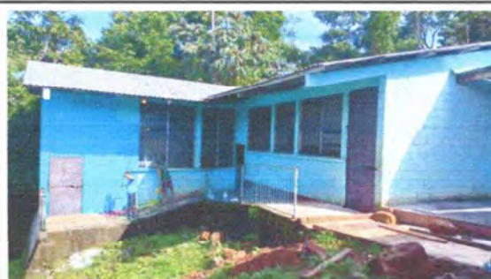
Foto 4: Se observa que se esta aplicando pinturas en los muros exteriores
