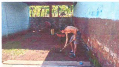
Foto 5: Se observa la conformacion de la torta de concreto
