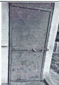
Foto 3: Se observan las puertas en mal estado, por tal motivo necesitan sustitución.
