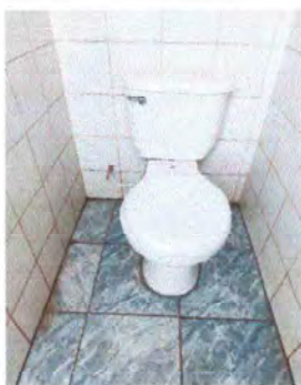
Foto 7: Se observa los sanitarios ya colocados
