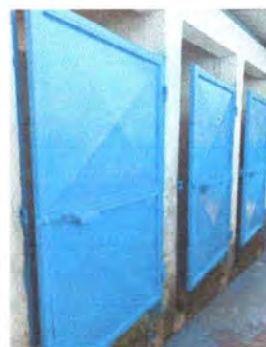
Foto 8: Se observa las puertas despues del mantenimiento
