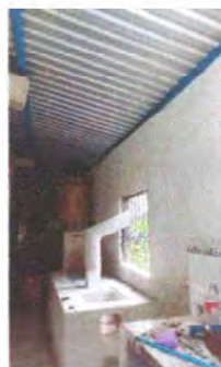
Foto 2: Se observa como quedo el muro
