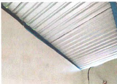
Foto 11: Se observa la lamina ya colocada
