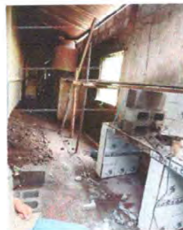
Foto 2: Se observa el muro en reparacion
