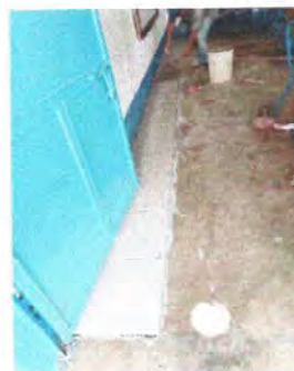
Foto 4: Se observva la coiocacion de piso
