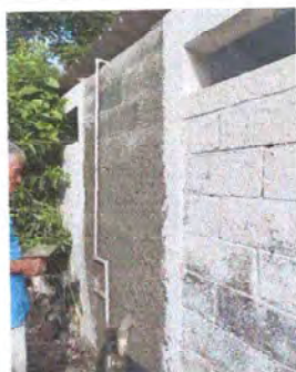
Foto 9: Se observa la reparación del muro
