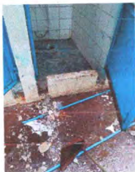
Foto 7: Se observa el cambio de los sanitarios
