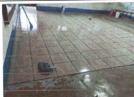
Foto 10: Se observa el cambio de piso
