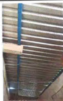
Foto 5: Se observa el cambio de lamina
