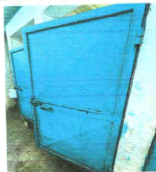
Foto 8: Se observa el mal estado de la puerta de los baños
