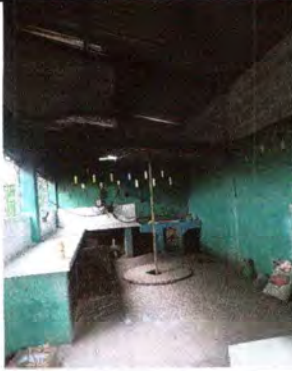
Foto 7: Se verifica que se ha conformado el muro.
