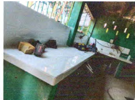
Foto 4: Instalación de azulejo en mueble de cocina
