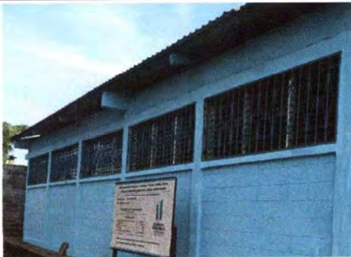
Foto 9: Se observa que ya se instalaron los balcones.
