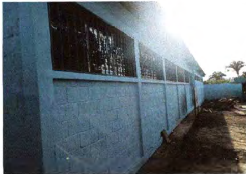
Foto 11: Aplicación de pintura en muro exterior terminada.
