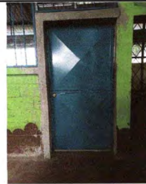
Foto 10: Se verifica que se ha instalado la puerta.
