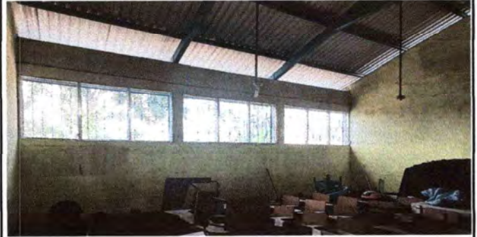
Foto 8: Instalación completa de ventanas de vidrio.
