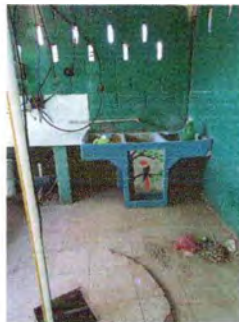
Foto 3: Cambio de pila de concreto de 2 lavaderos
