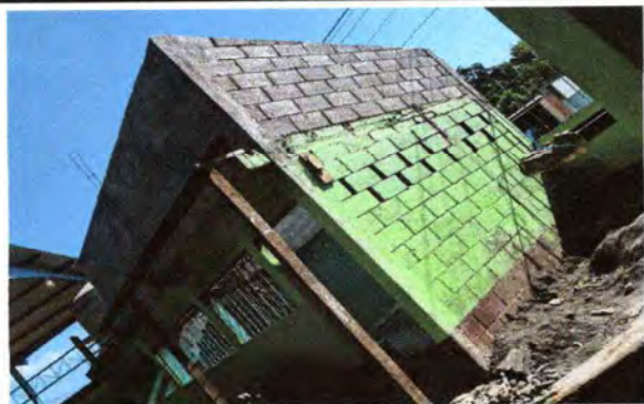
Foto 7: Se observa como se están colocando las hiladas de block conformando el muro.
