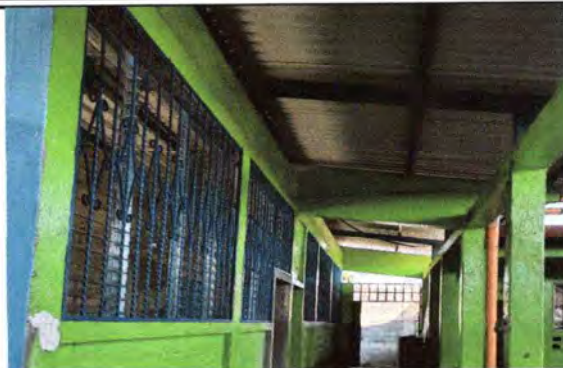
Foto 8: Instalación de ventanas de vidrio tipo paleta
