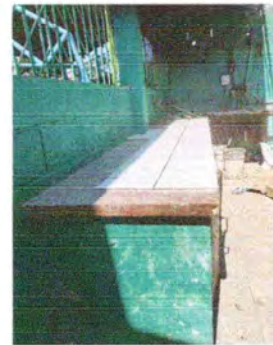
Foto 4: Proceso de instalación de azulejo
