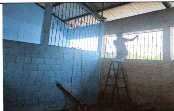
Foto 9: Se verifica la instalación de balcón.
