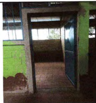
Foto 10: Colocación de puerta.
