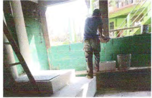
Foto 2: Proceso de conformación de ventana en cocina
