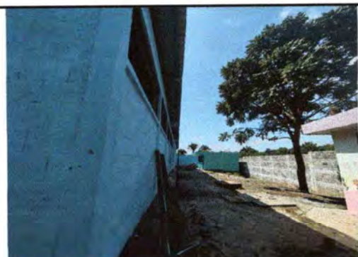
Foto 11: Proceso de pintura en pared exterior.
