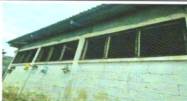
Foto 9: Se observa no se cuenta con balcones.
