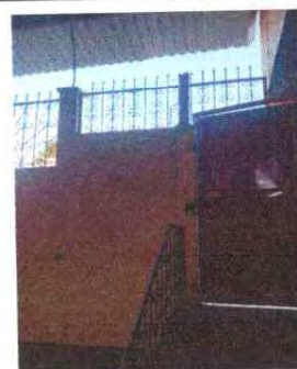
Foto 18: Se observa como quedo el balcon
