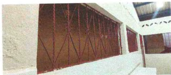
Foto 9: Se observa como quedo las ventanas
