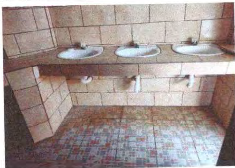
Foto 13: Se observa como quedaron los lavamanos
