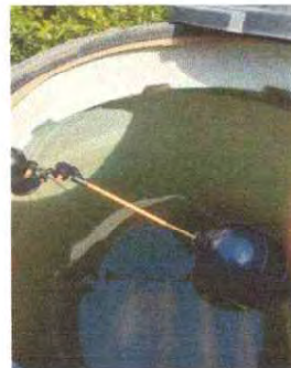
Foto 22: Se observa como quedo el rotoplas despues del cambio de accesorios
