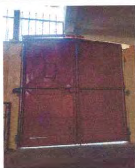
Foto 23: Se observa como quedo el cambio de porton
