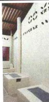
Foto 4: Se observa como quedo la chimenea
