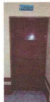
Foto 20: Se observa como quedaron las puertas
