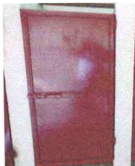
Foto 10: Se observa como quedaron las puertas
