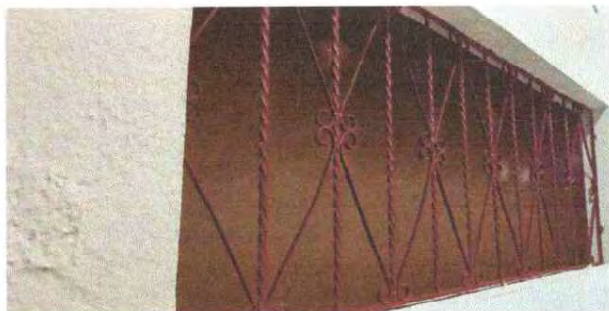
Foto 21: Se observa como quedaron los balcones
