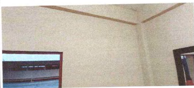
Foto 17: Se observa como quedo la aplicación de pintura
