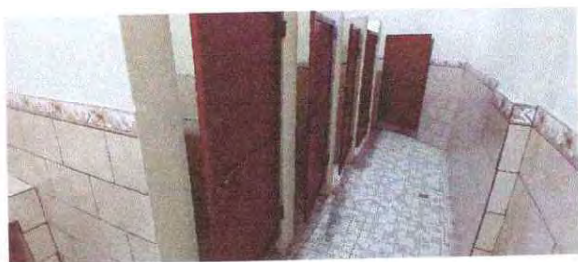
Foto 15: Se observa como quedaron las puertas
