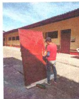
Foto 20: Se observa el mantenimiento de las puertas
