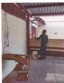
Foto 11: Se observa la aplicacion de pintura
