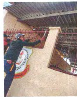
Foto 18: Se observa la colocación del balcón
