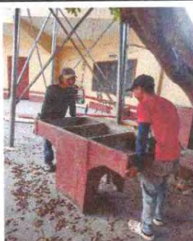
Foto 3: Se observa el cambio de la pila
