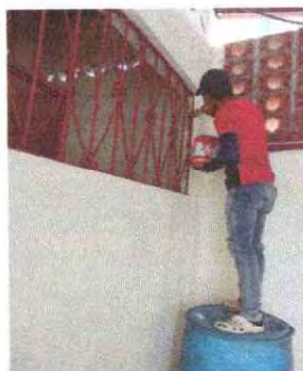
Foto 9: Se observa el mantenimiento a las ventanas
