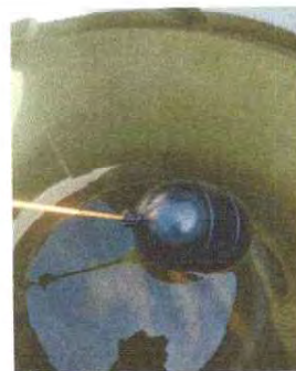
Foto 22: Se observa el cambio de accesorios del rotoplas
