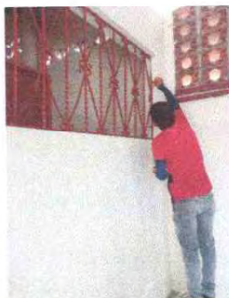
Foto 21: Se observa el mantenimiento a los balcones
