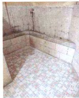
Foto 14: Se observa la reparación de migitorio
