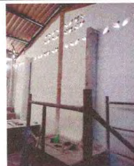
Foto 4: Se observa la reparacion de la chimenea
