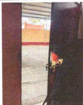
Foto 15: Se observa el mantenimiento a las puertas
