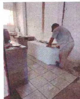
Foto 8: Se observa la colocacion de piso ceramico
