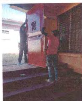
Foto 23: Se observa el cambio del porton
