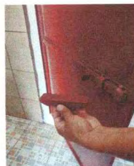
Foto 10: Se observa el mantenimiento a las puertas
