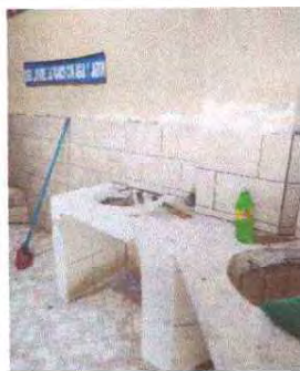
Foto 13: Se observa la reparación de lavamanos
