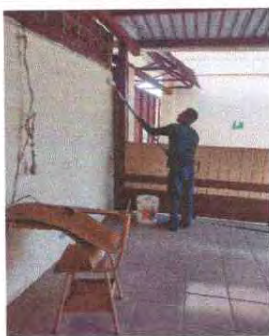
Foto 17: Se observa la aplicación de pintura
