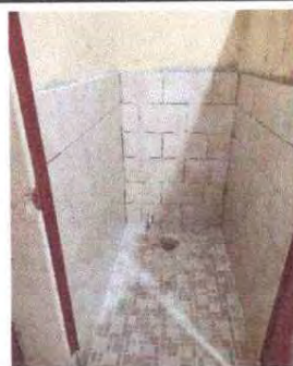
Foto 12: Se observa la sustitucion del sanitario
