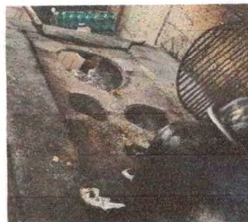
Foto 2: Se observa el mal estado de la plancha de metal de las estufas.
