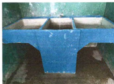
Foto 6: Se puede observar la nueva pila instalada.
