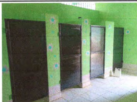
Foto 3: Se observa el mantenimiento realizado a las puertas de los baños.
