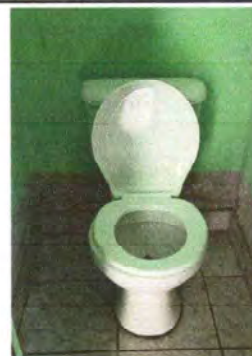
Foto 4: Se puede observar el nuevo inodoro colocado.
