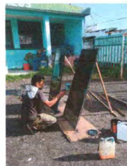
Foto 2: Se observa el trabajo para la colocación de puerta en los baños.
