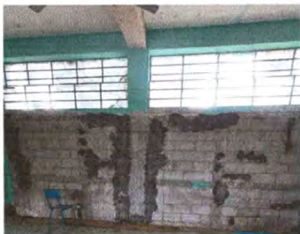
Foto 1: Se observa el inicio de la reparación del muro.
