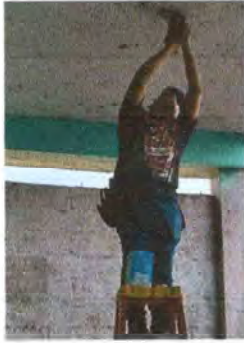
Foto 7: Se observa el cambio del sistema eléctrico.
