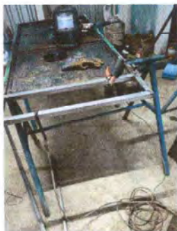
Foto 3: Se observa el inicio del mantenimiento de las puertas de los baños.
