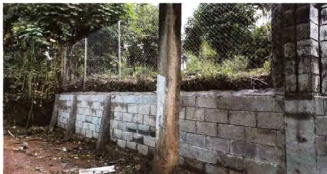
Foto 7: Se observa como quedo el muro de contencion
