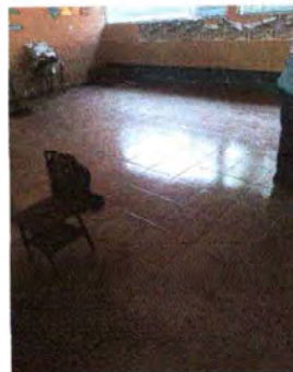
Foto 2: Se observa como quedó el piso en las aulas
