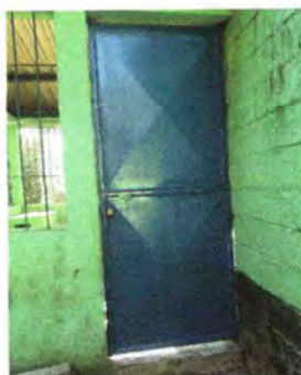
Foto 3: Se observa como quedó la sustitucion de la puerta
