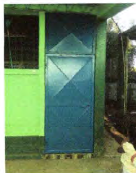
Foto 4: Se observa como quedó el mantenimiento de las puertas
