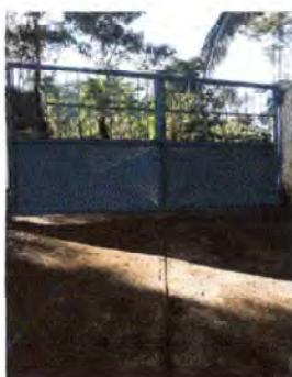
Foto 9: Se observa como quedo la sustitucion del porton
