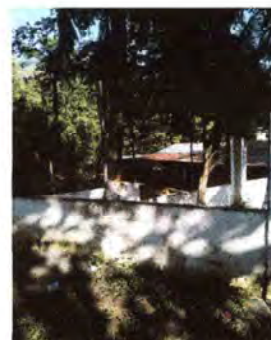
Foto 8: Se observa como quedo la sustitucion de la malla del muro
