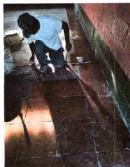
Foto 2: Se observa la colocacion de piso ceramico
