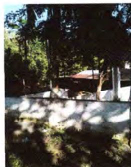
Foto 8: Se observa la sustitucion de la malla del muro
