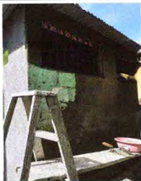
Foto 1: Se observa el proceso de repello de los muros del aula de parvulos
