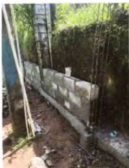
Foto 7: Se observa el proceso del muro de contencion
