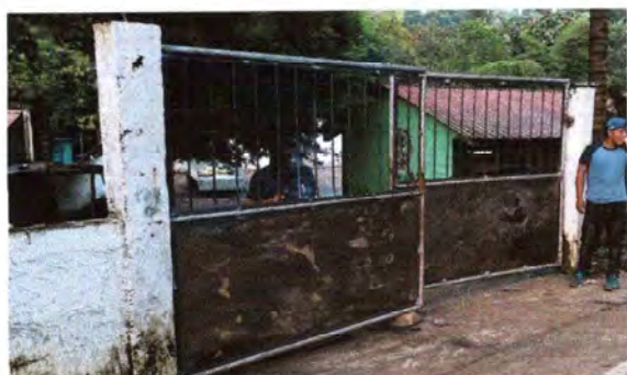
Foto 9: Se observa el cambio del porton
