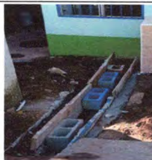
Foto 12: Colocando el tragante.
