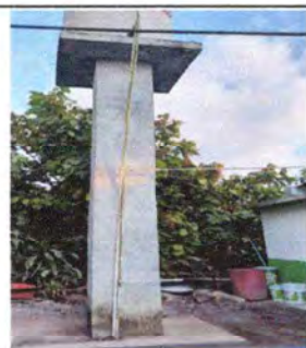
Foto 11: Instalación de tubería finalizado.
