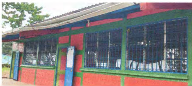
Foto 9: Se observa la necesidad de colocar canal pues ya no es funcional
