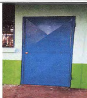
Foto 8: Instalación de puertas finalizado.
