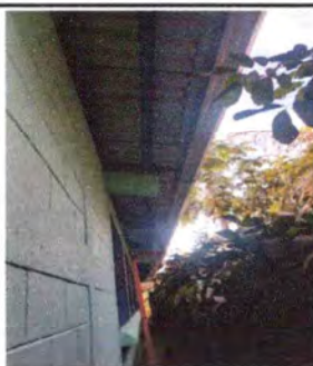
Foto 9: Instalación de canales completado.
