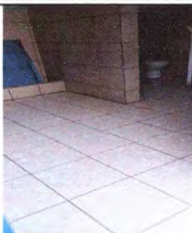
Foto 7: Instalación pisos cerámico finalizado.
