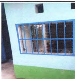
Foto 3: Instalación de balcon finalizado.
