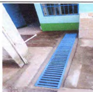
Foto 12: Instalación de tragante completado.
