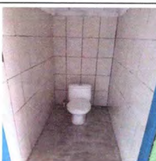
Foto 6: Instalación de azulejo de baños completado.
