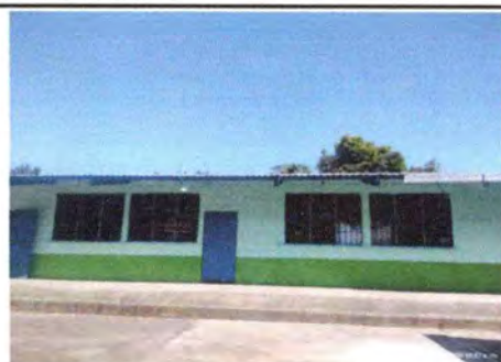
Foto 10: Resane de aplicación de pintura completado.
