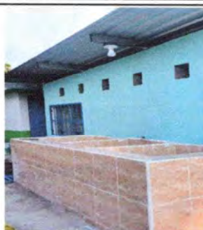
Foto 2: Construcción de pila terminado.
