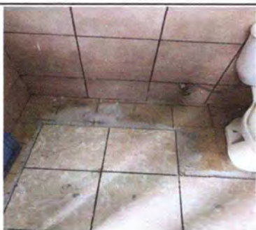
Foto 7: Colocando piso ceramico.
