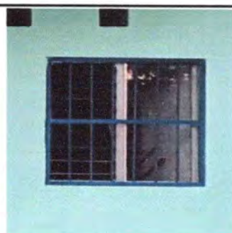
Foto 4: Instalación de ventana más vidrio terminado.
