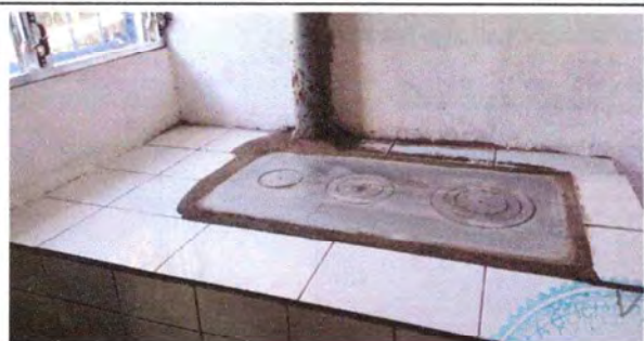
Foto 5: Instalación de plancha terminado.
