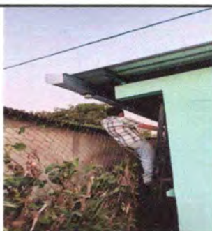
Foto 9: Instalando Canales.
