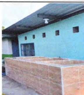
Foto 2: Construcción de pila terminado.
