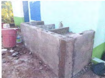
Foto 2: Construcción de la pila.
