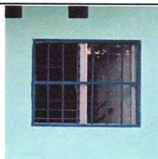
Foto 4: Instalación de ventana más vidrio terminado.
