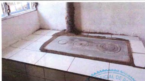
Foto 5: Instalando plancha de la estufa.
