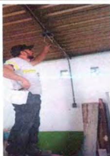
Foto1: Instalando el sistema eléctrico.
