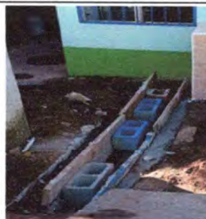
Foto 12: Colocando el tragante.
