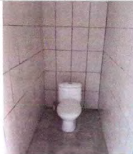
Foto 6: Colocando azulejo en los baños.
