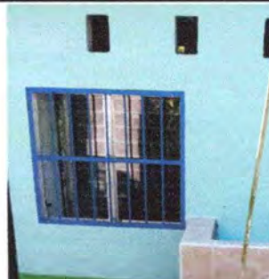
Foto 4: Instalación de ventana más vidrio.
