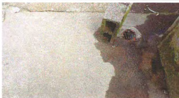
Foto 12: Se observa la necesidad de ampliar el tragante
