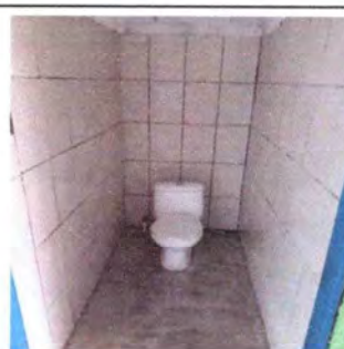
Foto 6: Instalación de azulejo de baños completado.
