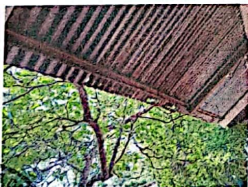
Foto 5: FOTOGRAFIA DEL ESTADO ACTUAL DE LA LÁMINA EN EL SALÓN, VISTA EXTERIOR
