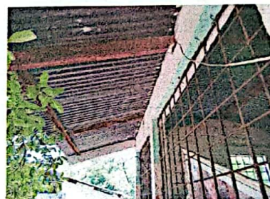
Foto 4: FOTOGRAFIA DEL ESTADO ACTUAL DE LA LÁMINA EN EL SALÓN, VISTA EXTERIOR
