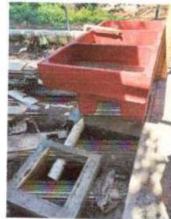
Foto 8: Se observa que la pila nueva ya fue colocada
