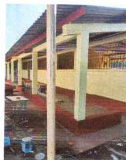
Foto 4: Se observa que los muros del modulo 1 ya fueron pintados
