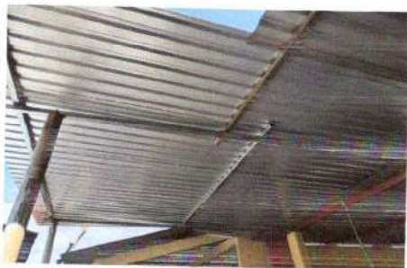
Foto 1: Se observa que la lámina de zinc, se encuentra en mal estado
