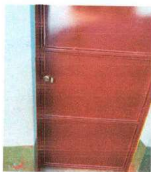
Foto 3: A Las puertas de los sanitarios ya se les dio mantenimiento
