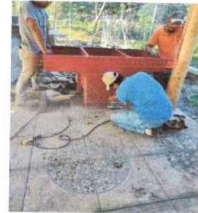
Foto 8: Se observa que la pila ueva ya está siendo colocada.
