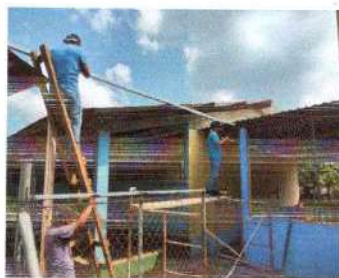
Foto 1: Se observa que la lámina de zinc, se ha removido y colocado la estructura de madera y colocado la de metal
