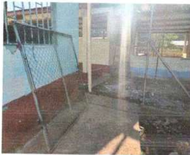
Foto 7: Se observa que ya se quitado el portón que da acceso a la cocina y el comedor
