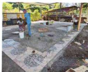
Foto 5: Se observa la colocación del piso cerámico en la cocina y el comedor
