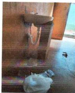
Foto 11: Se observa que a los lavamanos ya se les está colocando los grifos y drenaje que estaban dañados
