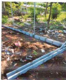
Foto 9: Se observa que la malla perimetral ya fue removida.
