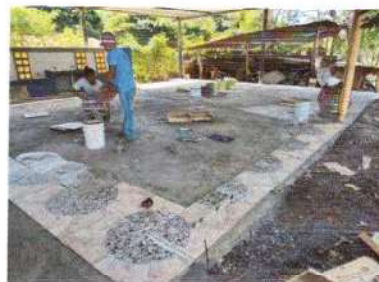
Foto 2: Se observa la colocación del piso cerámico en el área del comedor
