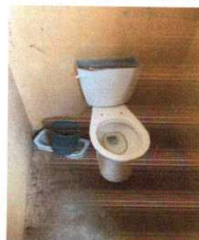
Foto 12: Se observa el mal estado de las tazas sanitarias. Tanto de los niños como de las niñas. Por dicha razón es necesario sustituirlas.
