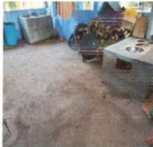
Se observa que el piso de la cocina y el comedor, ya está en malas condiciones. Para mejorarlo, es necesario instalar piso cerámico
