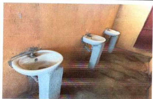
Foto 11: Se observa que los lavamanos que dar servicio a los sanitarios de niños como de las niñas, necesitan reparación por tener fugas de agua.
