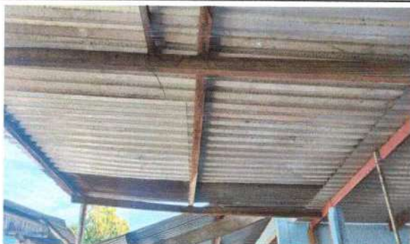
Foto 1: Se observa que la lámina de zinc, se encuentra en mal estado. Por dicha razón es necesario cambiar la lámina
