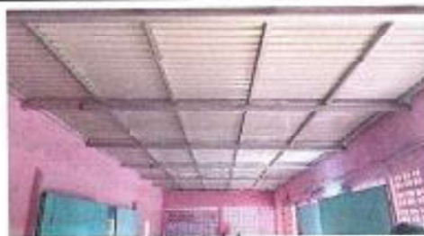
Foto 2: Se observa como quedo la estructura de soporte y lamina troquelada c29
