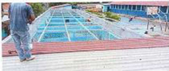
Foto 1: Se observa la conformación de mojinete mas estructura de soporte
