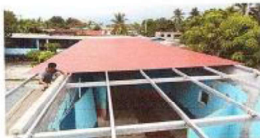
Foto 2 Se observa la colocacion de la lamina troquelada c28
