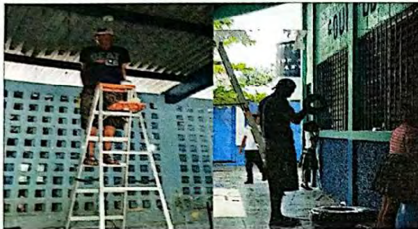
Foto13: Se procedió a realizar el cambio de plafoneras y demás accesorios por cada salón de clases para evitar aulas oscuras lo que dificultaba que algunos niños vieran la pizarra.
