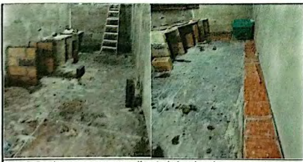
Foto 5: Se observa que se procedió a trabajar el suelo y prepararlo para colocar piso cerámico cubriendo la totalidad del cuarto de cocina.
