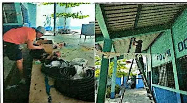
Foto 11: Se observa que se llevo acabo el cambio de linea principal de energia electrica desde contador hasta la caja de flipones la cual anteriormente estaba dentro de la direccion y fue coloco fuera de la misma ya que el cableado se habia
