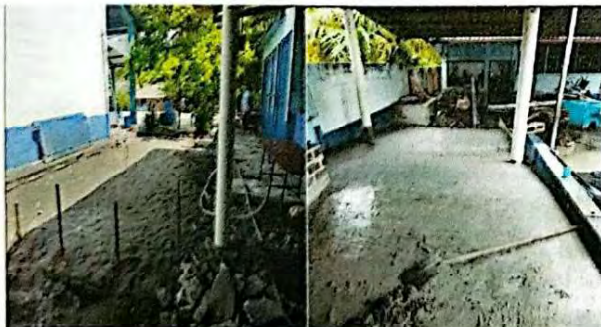
Foto 17: Debido a las malas condiciones de los suelos se procedió al levantado, relleno y emparejamiento del mismo para realizar nuevas planchas de concreto y evitar la acumulación de agua y suelos revalosos.
