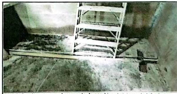
Foto 6: Se observa que al momento de cambiar el sistema de tubería se instaló la misma en el lugar donde quedará colocada la pila en área de cocina.
