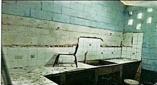
Foto 1: Se observa mejor el mal estado del azulejo por lo que se procedió a quitarlo para iniciar el proceso de cambio y colocar azulejo nuevo.
