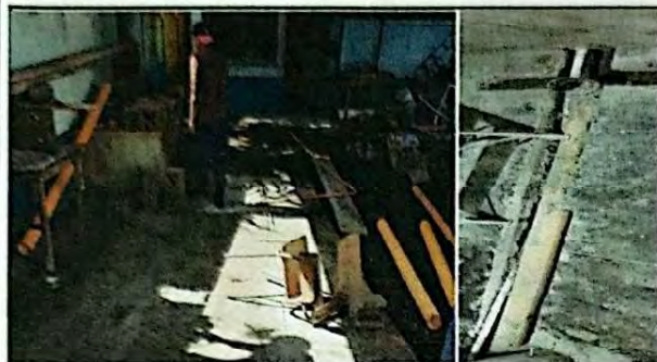
Foto 7: Se observa que se procedió al cambio de tubería nueva desde cajas principales hasta tubería para servicio de agua potable la cual quedara enterrada debajo de las planchas de concreto en patios y callejon.
