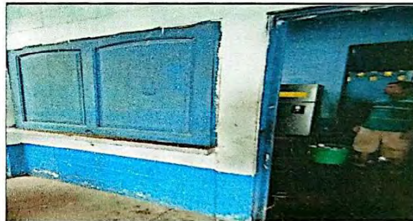
Foto 4: Se observa que los señores procedieron a quitar la ventana y llevarla para brindarle el mantenimiento necesario de lijado, seplado y pintada nuevamente así mismo asegurala en cambio de pasadores.
