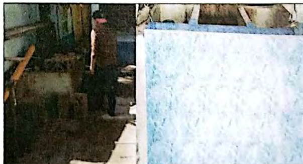
Foto 18: Se inició el mantenimiento del tanque de agua en repello, colocación de azulejo y cambios de chorros en el mismo como también el cambio de accesorios en lavamanos de los servicios sanitarios.
