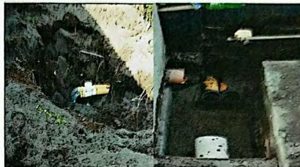
Foto 8: Se observa que se llevo a cabo el cambio de tubería principal en cajas de drenajes para evitar inundaciones en patios debido al mal estado de las mismas, realizando tambien sus tapaderas de concreto nuevas y
