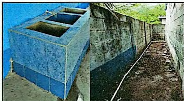
Foto 9: Se procedio a cambiar desde el sistema de tubería de agua potable y chorros en pila, lavamanos y tanques (piletas).
