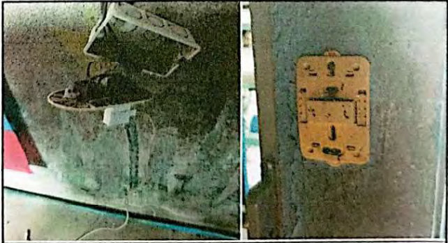
Foto 12: Se observa las malas condiciones de los tomacorrientes y apagadores de los salones de clases debido a la cercanía al mar y el salitre.
