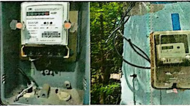
Foto 11: Se observa que la línea principal de energía eléctrica que va desde el contador hacia caja de flípones está dañada por completo lo cual requiere cambio de todo ese sistema eléctrico.
