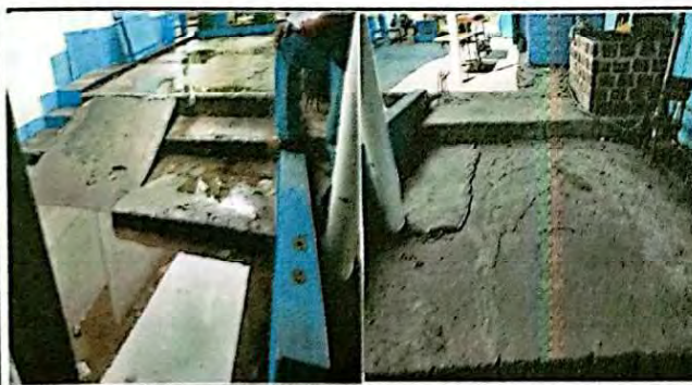
Foto 17: Se observa las planchas de concreto en malas condiciones al igual que rampas y escaleras lo cual ha provocado caídas en estudiantes y personal docente.
