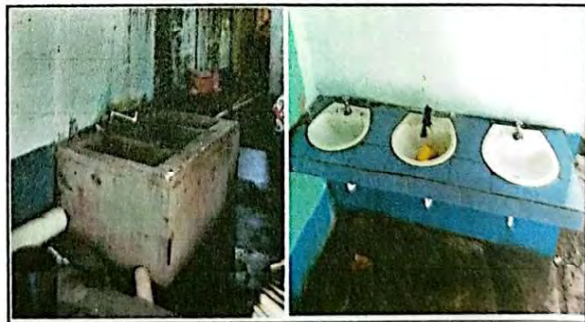
Foto 18: Se observa el tanque de agua en malas condiciones al igual que los chorros de los lavamanos de baños lo que se encuentra inhabilitados.
