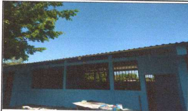
Foto 1: Se observa la sustitución de lamina por lamina troquelada aluzinc calibre 26 (incluye capote, tornillos, desmontaje y montaje)
