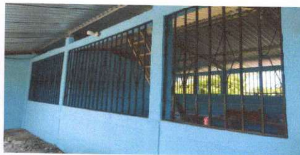
Foto 4: la Sustitución de malla por balcon.
