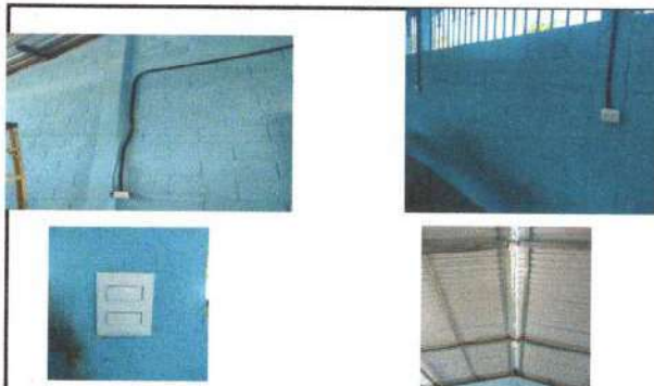
Foto 9: Sustitución de sistema eléctrico (3 luminarias, 3 tomacorrientes, 1 apagador y cableado)
