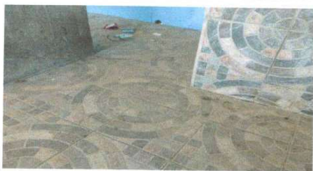
Foto 5: Suministro e instalación de piso cerámico
