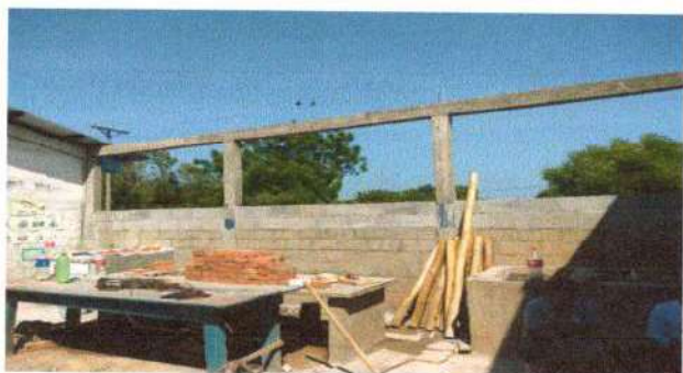
Foto 3: la reparación de muro de block (incluye columnas y soleras)
