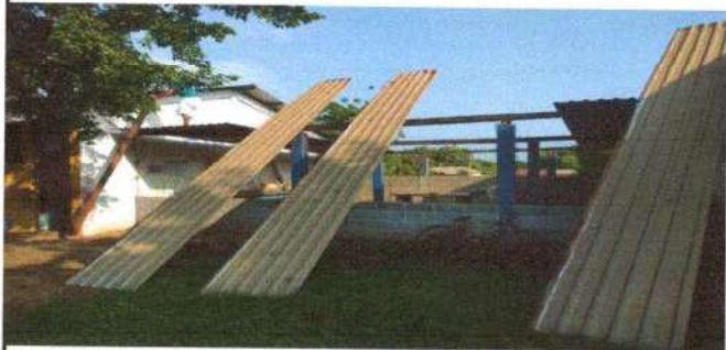
Foto 1: Se observa la sustitución de lamina por lamina troquelada aluzinc calibre 26 (incluye capote, tornillos, desmontaje y montaje)
