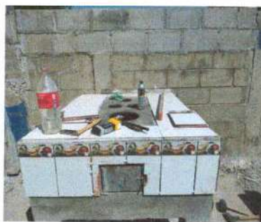
Foto 6: la Sustitución de estufa rural ( completa) incluye chimenea y plancha de metal
