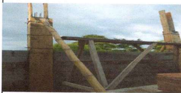
Foto 4: la Sustitución de malla por balcon.
