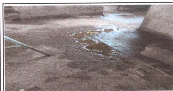
Foto 5: El piso de cemento esta en mal estado por lo que es necesario el Suministro e instalación de piso cerámico
