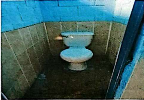
Foto 7: Se observa el trabajo de colocacion de piso ceramico en el modulo de baños en mal estado
