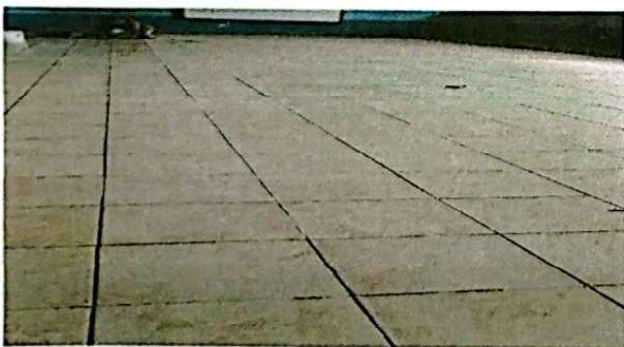
Foto 11: Se observa la colocacion del piso ceramico en el modulo de aulas.
