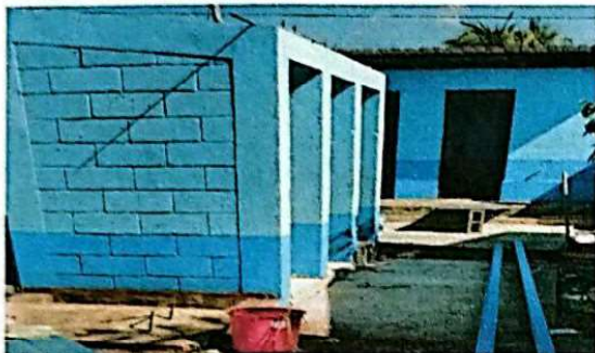
Foto 1. Se observa el trabajo del cambio de las laminas del modulo de baños.
