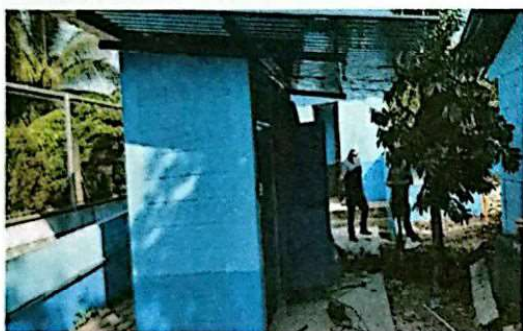
Foto 3: Se observa el trabajo de la colocacion de puertas de metal en los baños.
