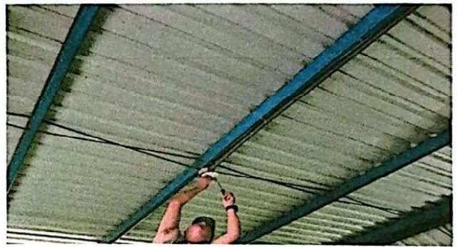
Foto 10: Se observa el trabajo de cambio del sistema electrico.
