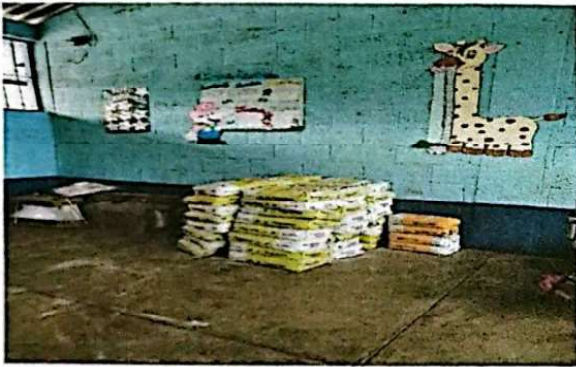
Foto 9: Se observa el material para colocar torta de cemento donde estaran los lavamanos.
