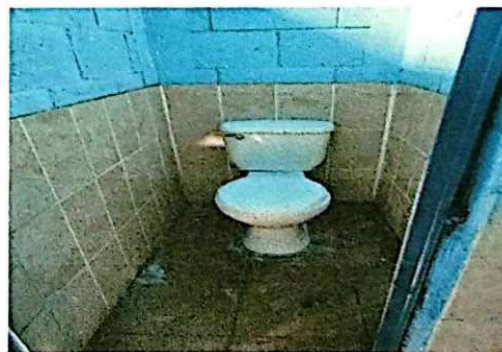
Foto 4: Se observa el cambio de las letrinas y la colocacion de piso ceramico.
