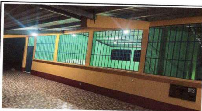
Foto 5: Se observa instalacion de luz terminada.
