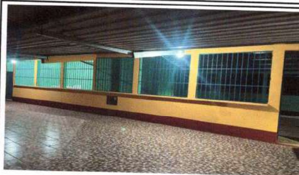
Foto 2: Se observa pintura y repello termina en aulas
