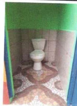
Foto 4: Se observa piso ceramico terminado en baños.
