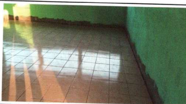
Foto 6: Se observa piso ceramico terminado en aulas.
