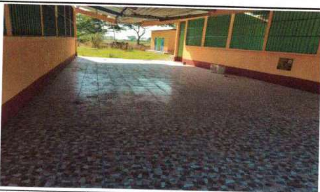
Foto 3: Se observa pisode granito terminado en pacillo de aulas
