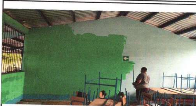
Foto 2: Se observan trabajos de pintura de aulas
