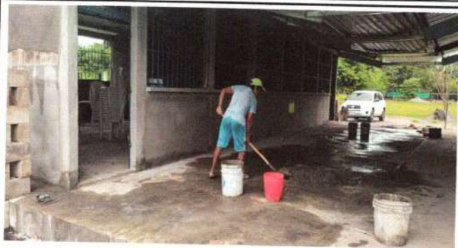
Foto 1: Se observan trabajos para repello de aulas.
