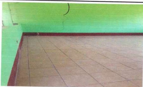
Foto 5: Se observa trabajo de intalacion de luz
