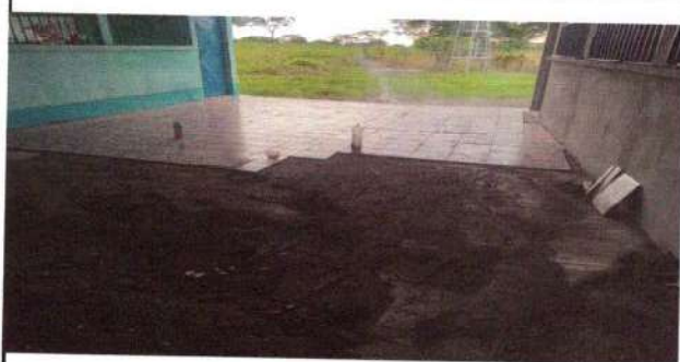
Foto 3: Se observan trabajos de colocada de piso en pacillo y aulas
