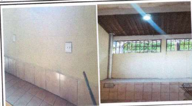
Foto 7: Sustitución sistema eléctrico, materiales y mano de obra cocina
