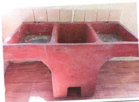
Foto 3: se observa pila de cemento sustitucion y cambio de lugar
