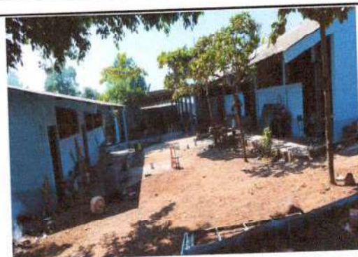
Foto 10: pintura latex en paredes interiores y exteriores de todas las aulas
