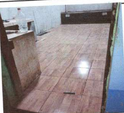
Foto 4: se observa el piso ceramico en cocina
