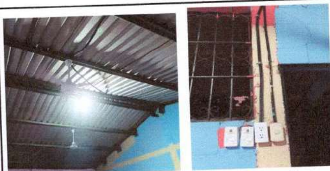
Foto 12: sustitución sistema eléctrico, modulo 2
