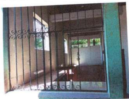
Foto 5: sustitucion balcones de metal cocina
