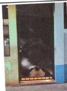
Foto 6: Reparación puerta de metal
