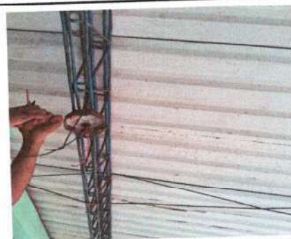
Foto 12: sustrucción sistema electrico, modulo 2
