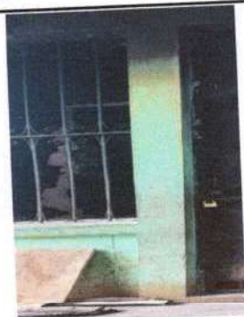
Foto 5: sustitucion balcones de metal cocina
