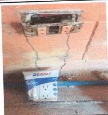
Foto 7: Sustrucción sistema electrico, materiales y mano de obra cocina
