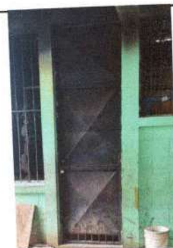
Foto 6: Reparación puerta de metal
