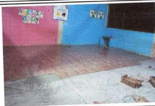
Foto 8: piso aulas torta de cemento por piso ceramico
