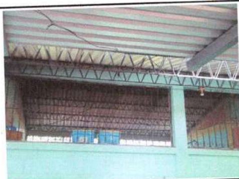
Foto 11: Reparacion mantenimiento balcones de metal
