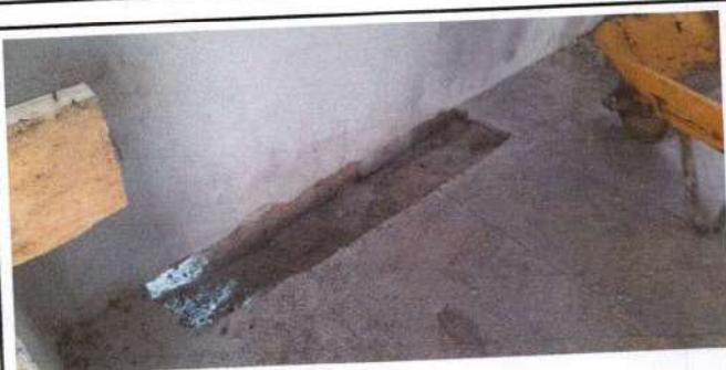
Foto 3: se observa pila de cemento sustitucion y cambio de lugar
