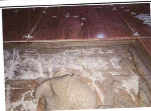
Foto 4: se observa el piso de cemento liquido
