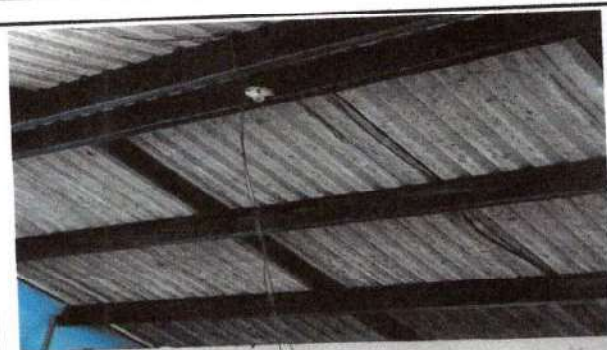
Foto 12: Sustitución sistema eléctrico, modulo 2
