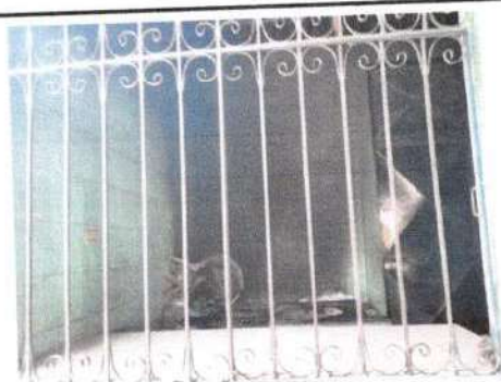
Foto 5: Sustitucion balcones de metal cocina
