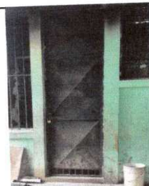
Foto 6: Reparacion puerta de metal
