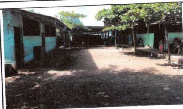
Foto 10: Pintura latex en paredes interiores y exteriores de todas las aulas
