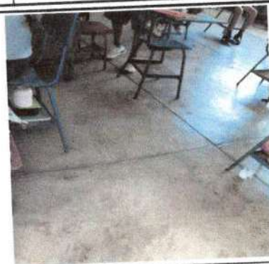
Foto 8: piso cocina torta de cemento por piso cerámico, aulas
