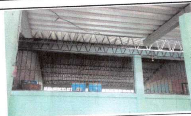
Foto 11: Reparación mantenimiento balcones de metal
