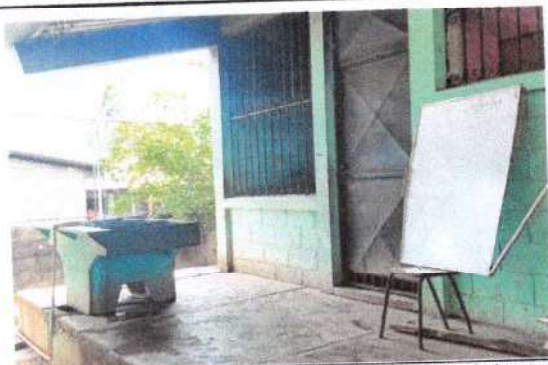
Foto 3: Se observa pila de cemento sustitucion y cambio de lugar
