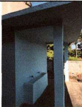
Foto 7: Se observa la finalización de resane en paredes
