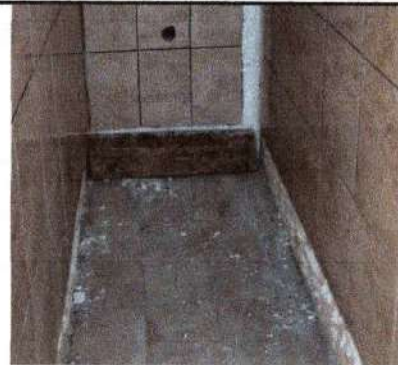
Foto 4: Se observa la finalización en el cambio del piso cerámico
