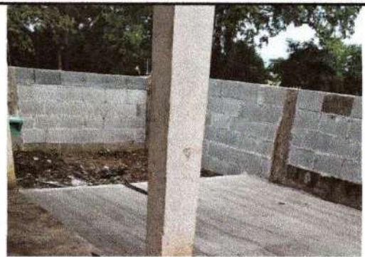
Foto 8: Se observa la finalización para reparar el muro perimetral
