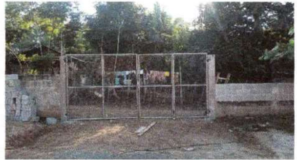
Foto 14: Se observa la finalización al instalar un porton para mayor seguridad
