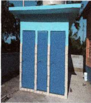
Foto 1: Se observa la finalización de la sustitución de las puertas
