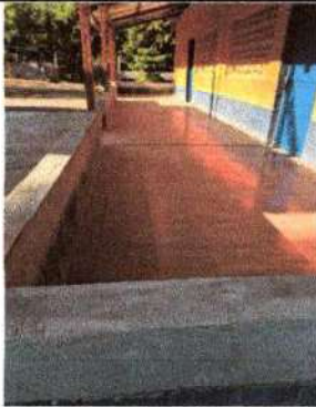
Foto 13: Se observa la finalización en piso modulo aula 2
