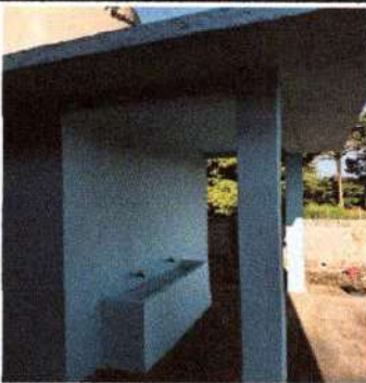
Foto 5: Se observa la finalización en el resane y pintura latex en paredes
