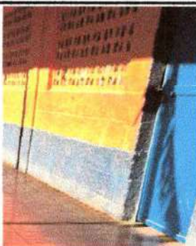
Foto 11: Se observa se observa la finalización de cambio de chapa para aulas modulo 2
