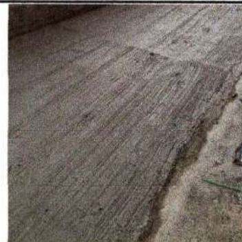
Foto 6: Se observa la finalización en la torta de concreto para el lavado de manos
