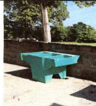
Foto 2: Se observa la finalización del cambio de la pila deteriorada por la nueva
