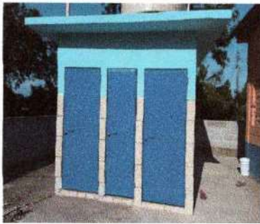
Foto 3: se observa la finalización al instalar el azulejo
