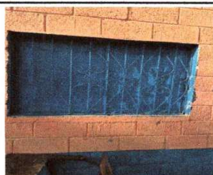
Foto 12: se observa la finalización de implementacion de balcón
