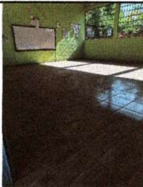
Foto 9: se observa la finalización en la instalación de piso cerámico
