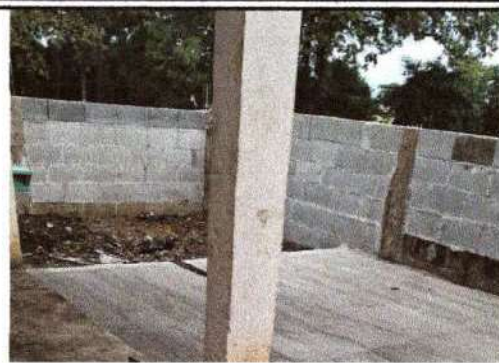
Foto 8: Se observa el avance para reparar el muro perimetral
