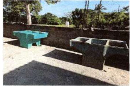
Foto 2: Se observa el cambio de la pila deteriorada por la nueva
