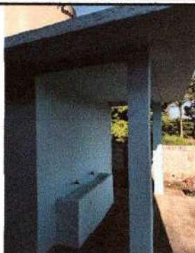
Foto 7: Se observa el avance de resane en paredes
