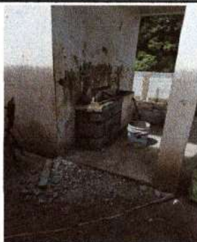
Foto 5: Se observa el avance en el resane y pintura latex en paredes
