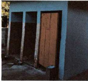
Foto 1: Se observa el avance en la sustitución de las puertas
