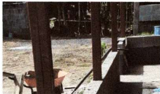
Foto 14: Se observa el avance al instalar un porton para mayor seguridad
