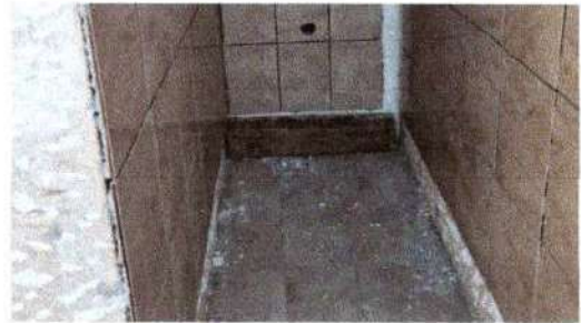
Foto 4: Se observa el avance en el cambio del piso cerámico
