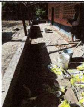
Foto 13: Se observa el avance en piso modulo aula 2
