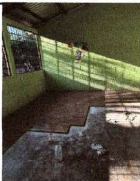
Foto 9: se observa el avance en la instalación de piso cerámico
