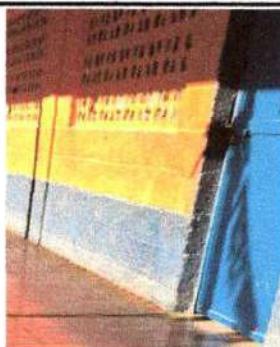
Foto 11: Se observa el avance de cambio de chapa para aulas modulo 2
