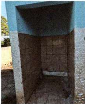
Foto 3: se observa el avance al instalar el azulejo
