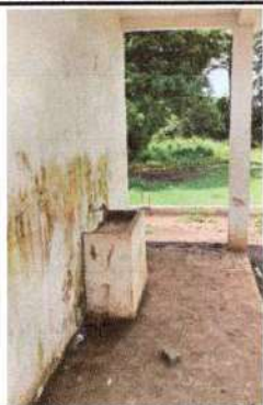
Foto 7: Se observa una de las paredes para resane
