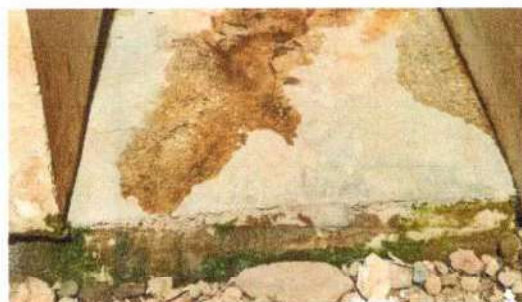
Foto 6: Se observa la necesidad de torta de concreto para el lavado de manos
