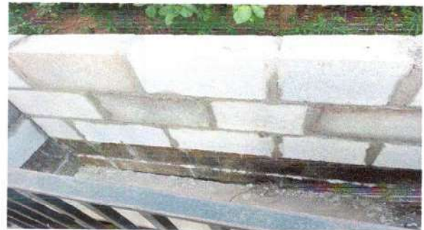
Foto 4: Se observa el muro terminado
