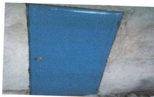
Foto 10: Se observa la puerta ya terminada
