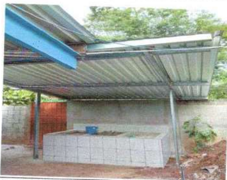
Foto 7: La pila se observa terminada
