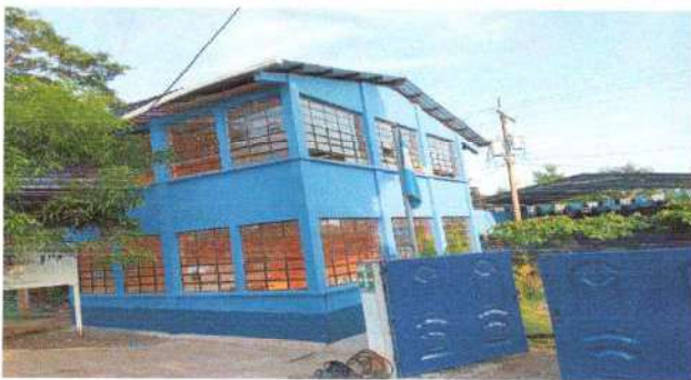
Foto 3: Las paredes se encuentran finalizadas en pintura
