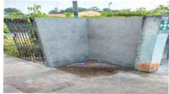
Foto 2: Se observa que el muro ya esta terminado
