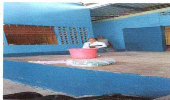
Foto 6: Las paredes se encuentran pintadas
