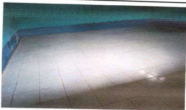
Foto 11: Se observa el piso ya instalado
