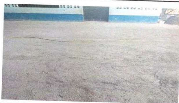
Foto 9: Se observa la plancha de concreto terminada
