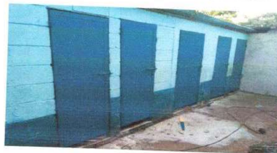
Foto 8: Se observa las puertas ya terminada
