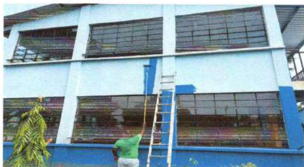
Foto 3: Se observa que las paredes estan en proceso de pintura
