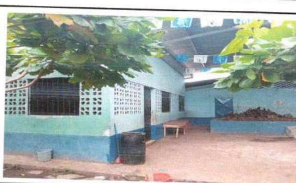
Foto 12: En proceso de pintura en pared
