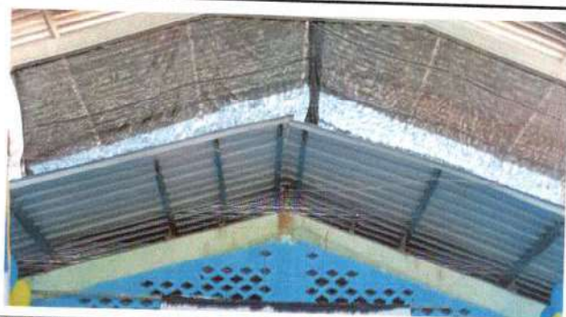
Foto 11: En proceso de pintura en paredes
