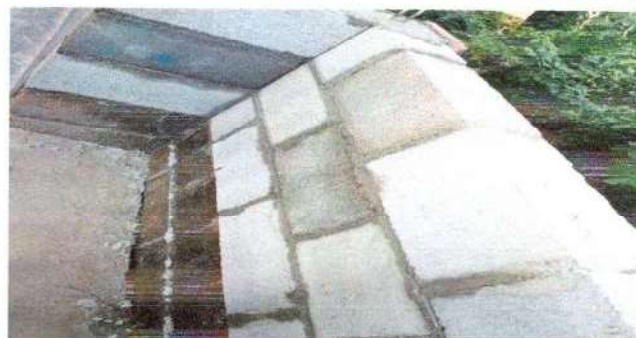
Foto 4: En proceso de conformacion de muro
