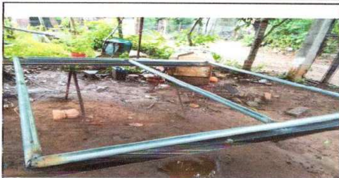
Foto 1: Se observa la elaboración del portón
