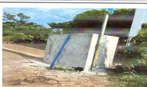
Foto 2: Se observa que el muro esta en proceso de repello
