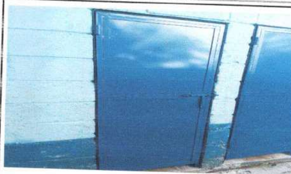
Foto 8: En proceso de colocación de puertas
