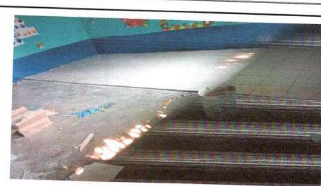
Foto 10: En proceso de pegado de cerámico
