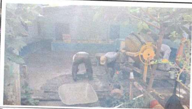
Foto 9: En proceso de elaboración de plancha
