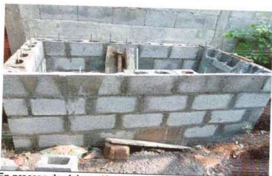
Foto 7: En proceso de elaboración de pila
